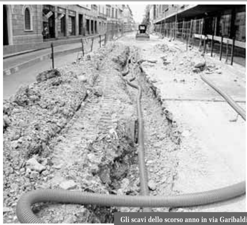
Gli scavi dello scorso anno in via Garibaldi
