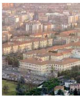
Il complesso degli Ospedali Riuniti
