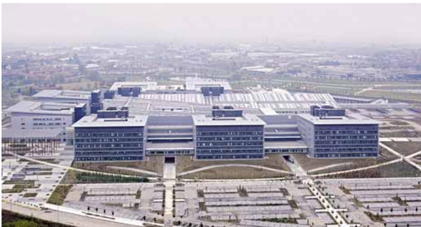
Il nuovo ospedale di Bergamo in una veduta aerea: ora gli imprenditori che hanno lavorato in subappalto chiedono ai Riuniti di essere saldati
